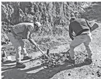
Personal municipal trabaja en la localización de válvulas de control del sistema de agua potable del centro cantonal, con el objetivo de zonificar cada sector y en casos de cortes de agua no afectar a todos los usuarios.
